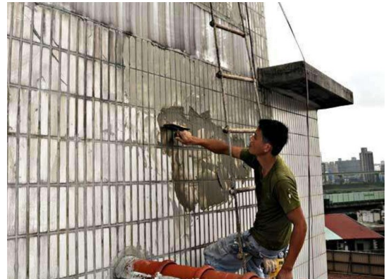
图2 防水砂浆施工作业
