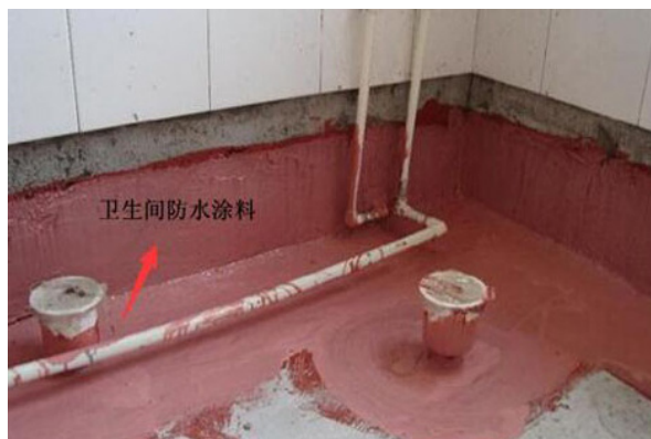
图3 卫生间防水作业
