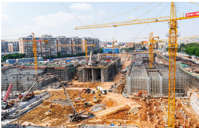
图1 建筑工程施工现场
