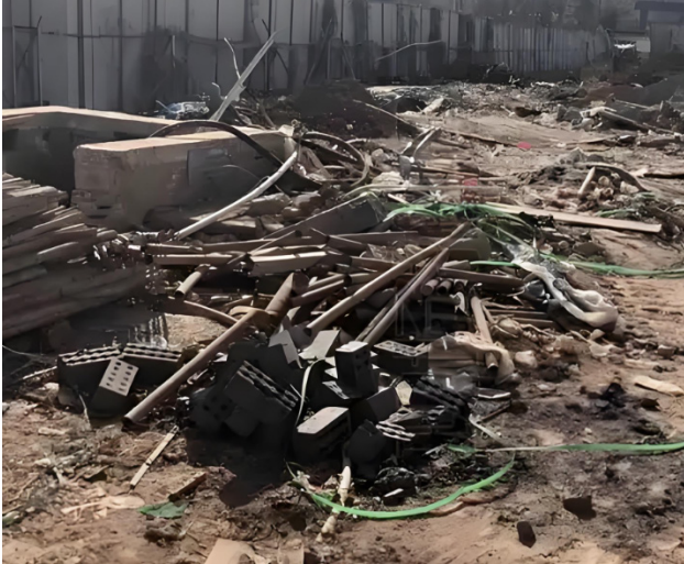
图1：建筑工程监理不足导致材料堆放混乱
