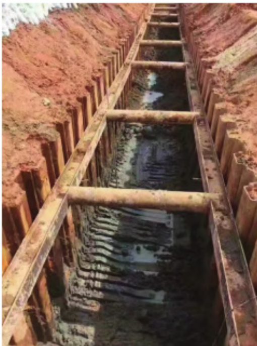
图1 雨污分流管网沟槽开挖和支护实景图
