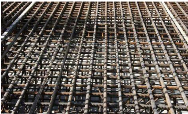
图一：钢筋绑扎
