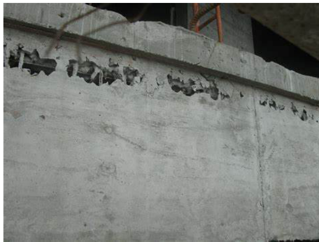
图一：混凝土振捣不密实
