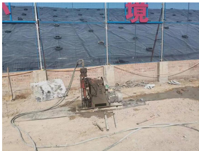
图1：房屋建筑土木工程注浆技术施工现场
