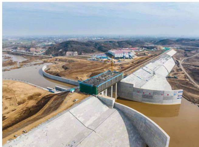
图 1 某地区水利工程建设
