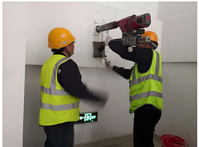
图1：取芯法检测混凝土结构强度
