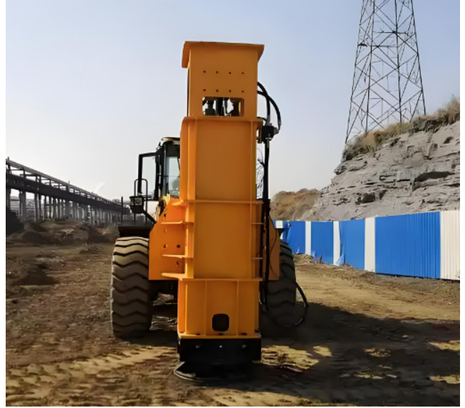
图1 强夯机夯击地基
