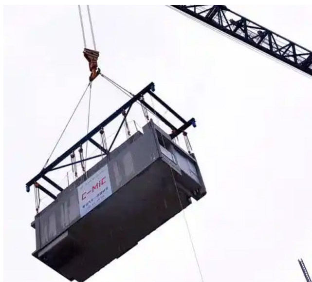
图 1: 模块化施工
