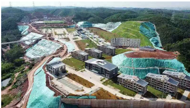
图1 广西飞碟靶场训练比赛基地项目现场施工图
