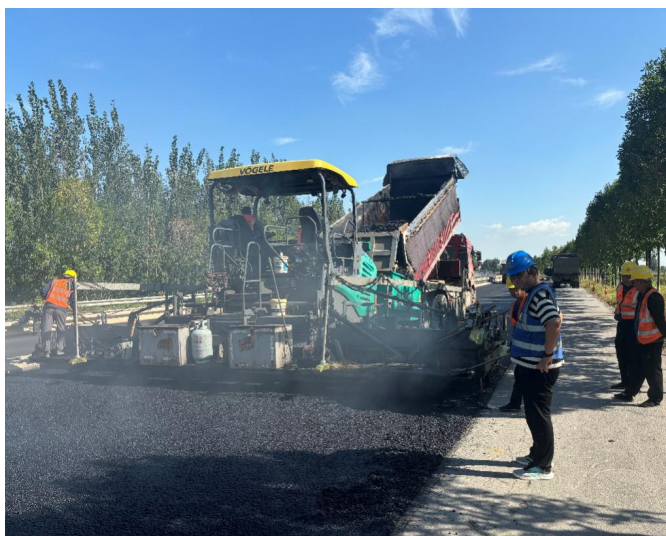
图 1 改性沥青混合料铺设
