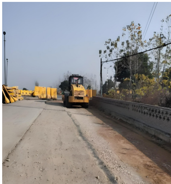
图1 路基路面碾压
