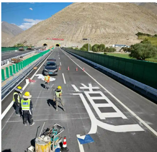
图2 道路标线施工
