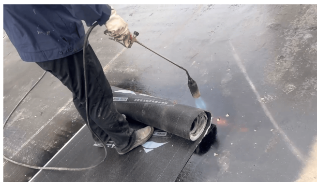
图2 防水卷材施工
