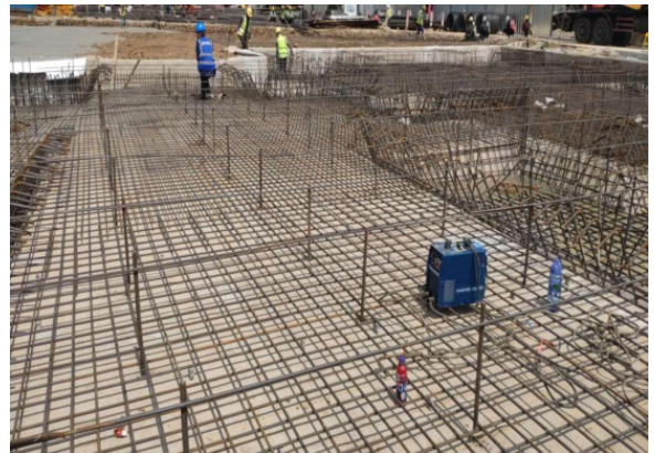
图2 基础施工现场(钢筋绑扎)
