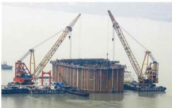
图1 水利围堰施工现场图
