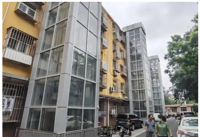
图2：老旧小区楼栋加装电梯
