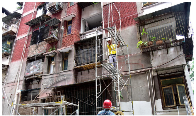
图1：老旧小区工程改造
