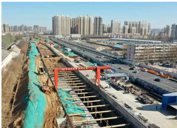
图3：管廊主体结构施工
