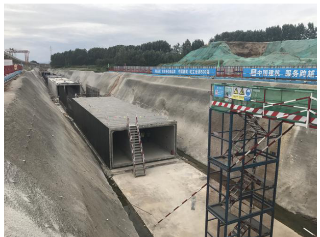
图2: 地下综合管廊深基坑施工
