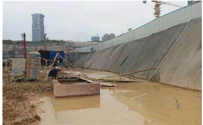
图二: 基坑积水
