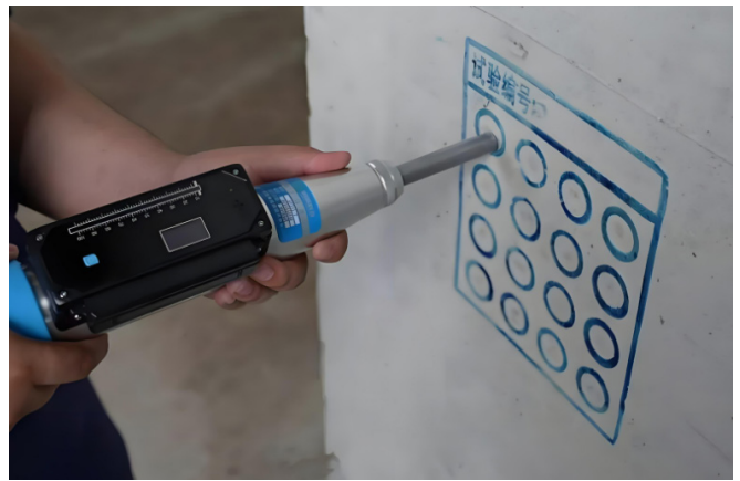
图1 回弹法检测混凝土强度
