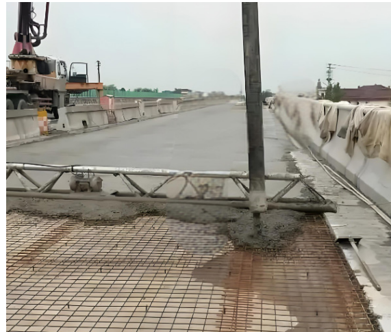
图 1 混凝土浇筑施工现场
