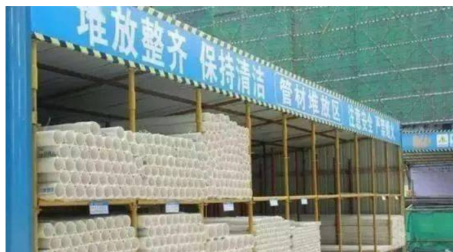
图1：施工材料现场
