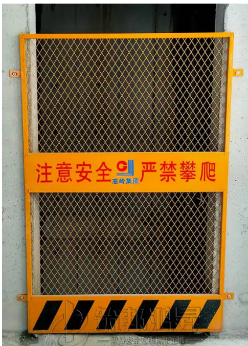
图1: 电梯井洞口安全标志
