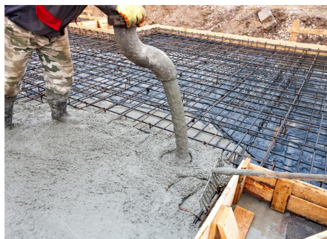
图1:混凝土灌注桩基施工
