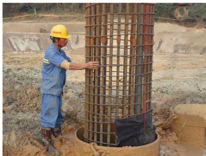
图二：灌注桩施工图
