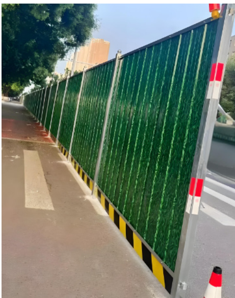
图1 施工安全新型围挡图
