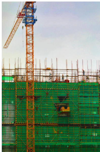
图 1 绿色建筑工程技术施工现场
