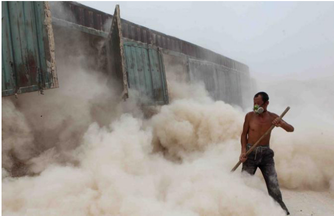
图一：施工粉尘污染
