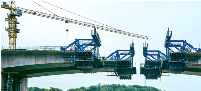
图1 桥梁施工悬臂浇筑法
