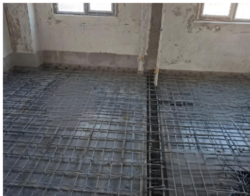
图 1 钢筋绑扎现场图
