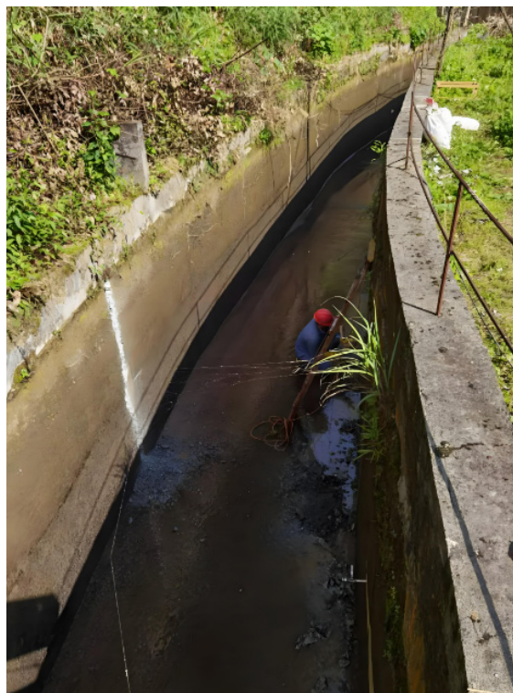
图2 水利渠道养护
