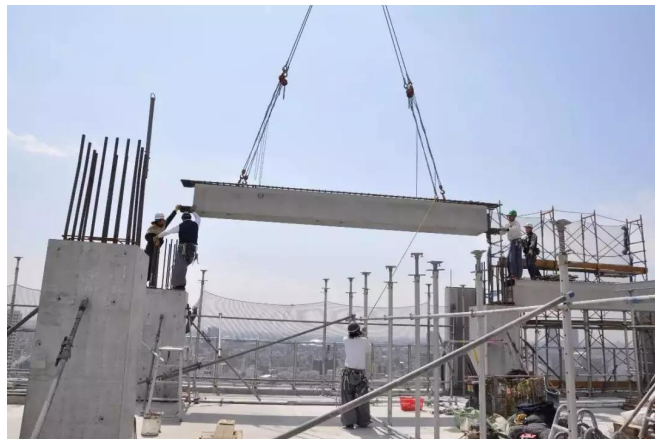
图2 预制预应力混凝土装配整体式技术
