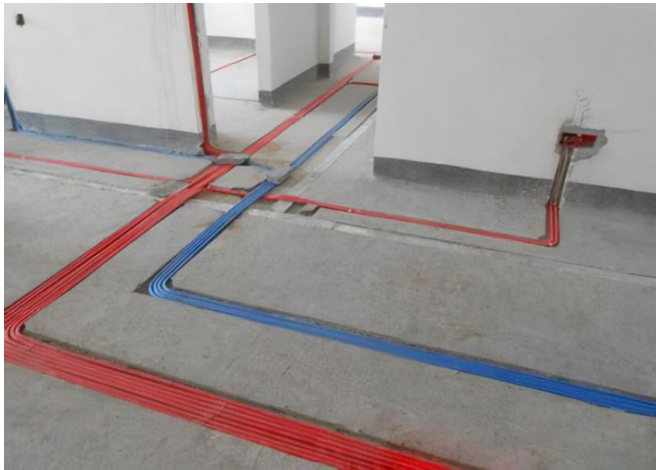
图一：水电暗线装修布线图
