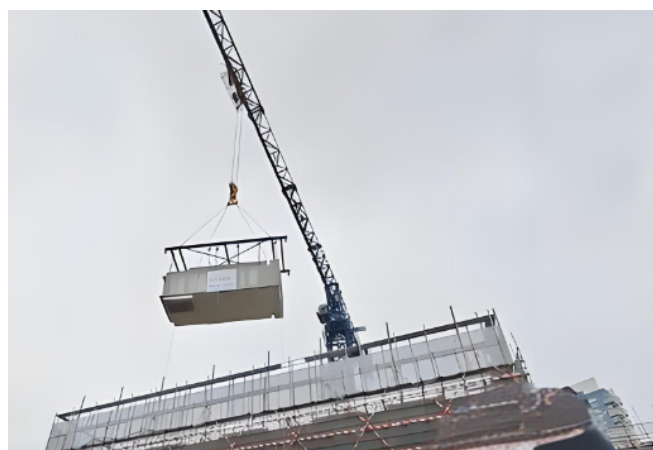
图 1 施工过程中模块吊运施工
