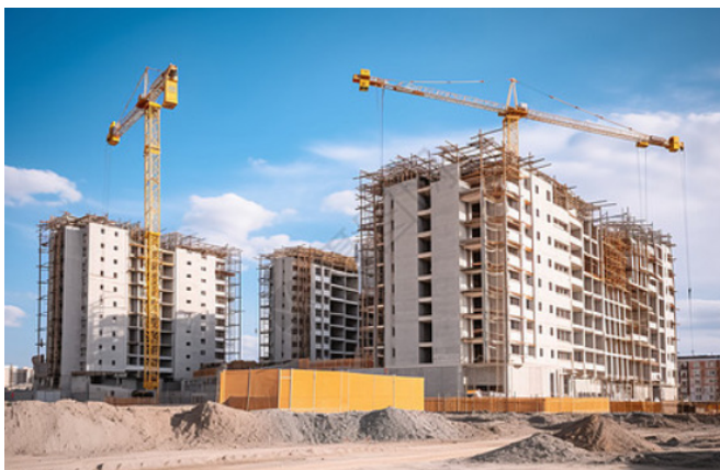
图1 高层住宅建筑施工现场
