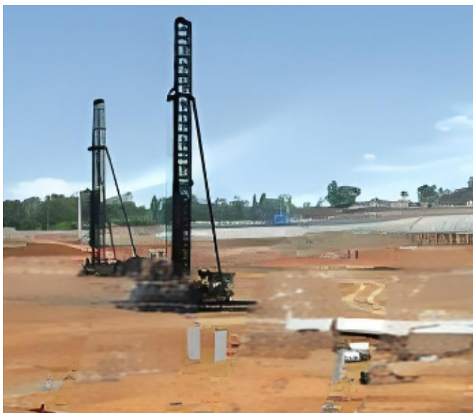
图1 预应力管桩复合支护结构施工现场
