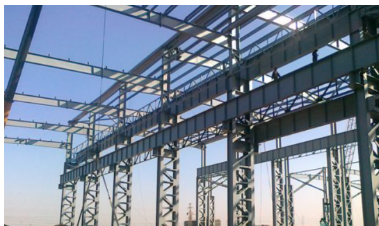
图一：钢结构厂房吊装
