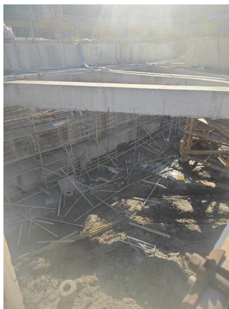
图 2 支护施工现场示意图
