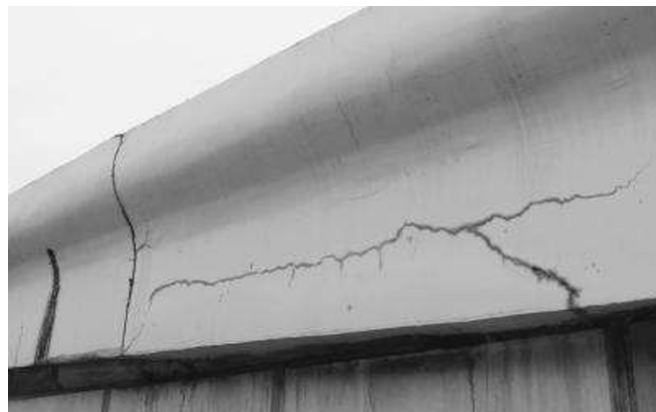
图2 温度裂缝
