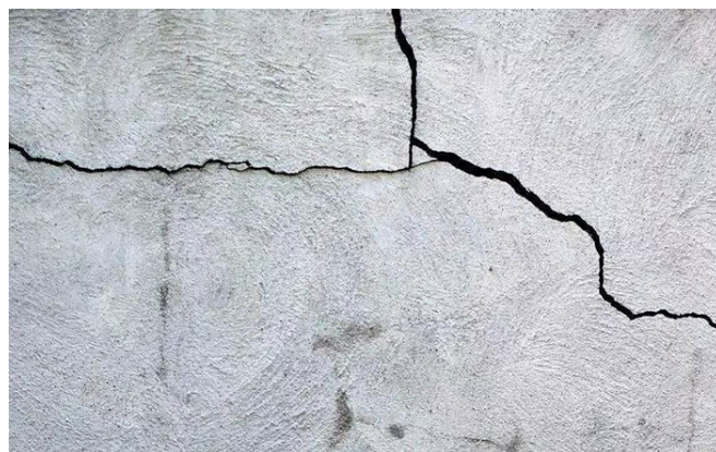
图1 荷载裂缝
