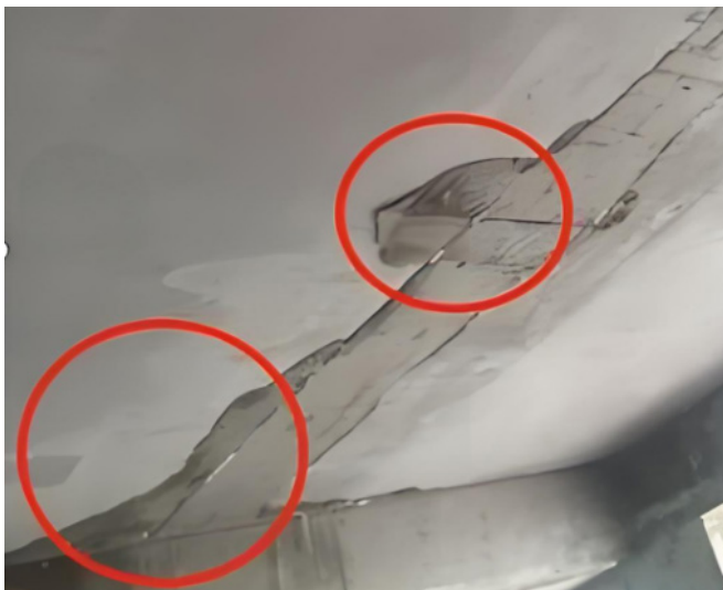
图 1 模板间接缝过大的问题
