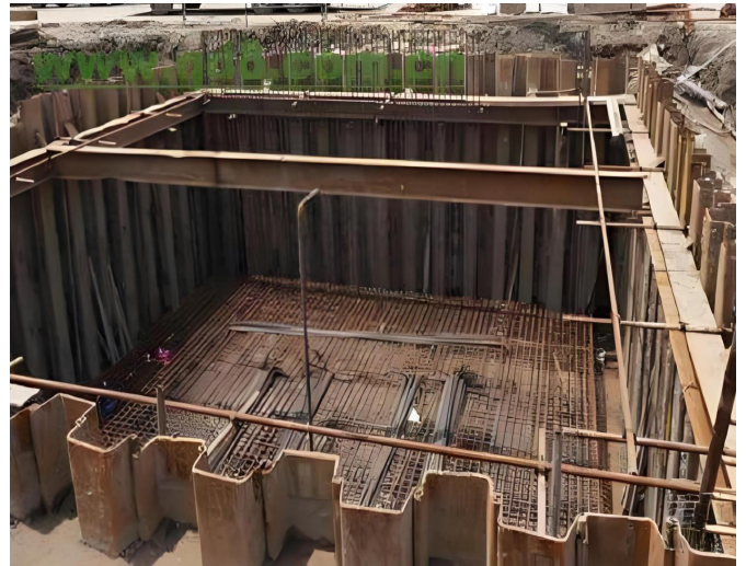
图1 深基坑支护
