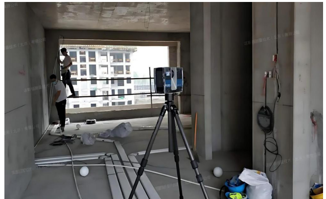
图1 激光扫描技术现场应用
