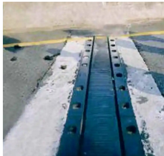
图2 橡胶式伸缩缝示意图
