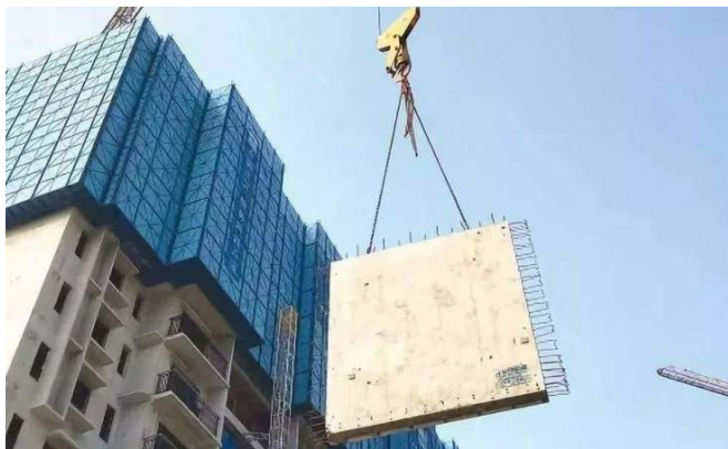
图2 预制构件吊装
