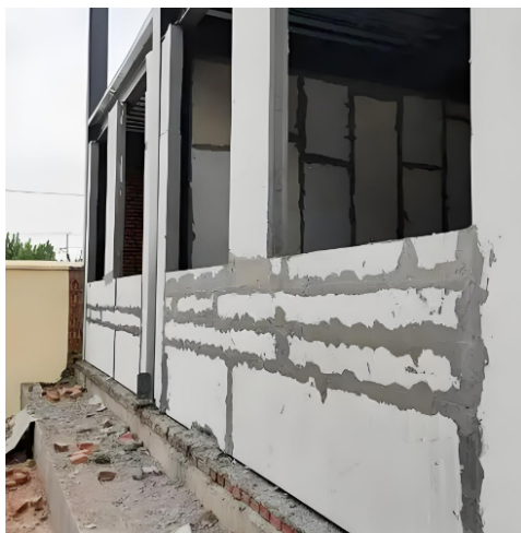
图1 密肋复合墙体施工图
