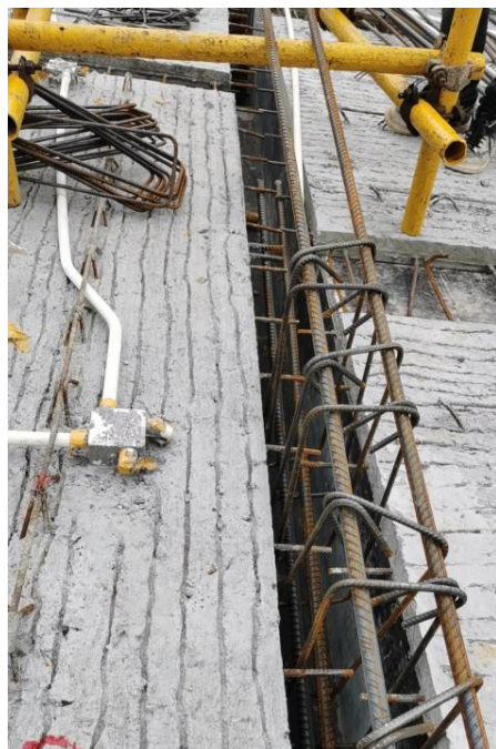
图 7 现场架梁钢筋绑扎图
