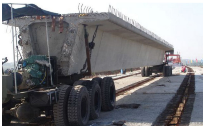
图 2 现场的箱梁运输
