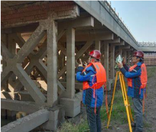
图二 桥梁现场检测
