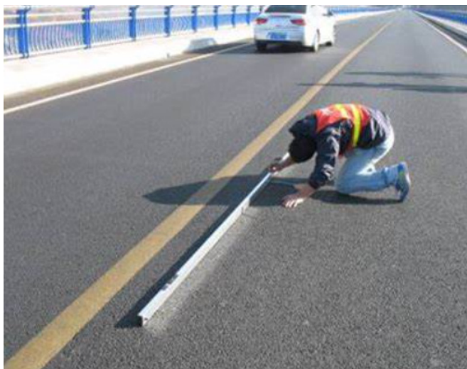
图一 市政道路现场检测
