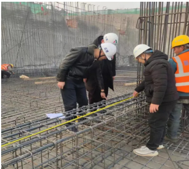
图3 施工质量检查
